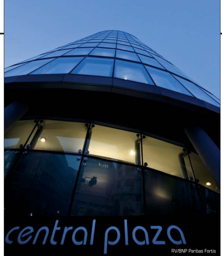
C'est le logiciel Prog'Time de Micromedia qui gère aujourd'hui le système d'éclairage central des bâtiments.
